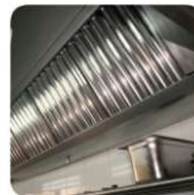
Dégraissage des Hottes de Cuisine
